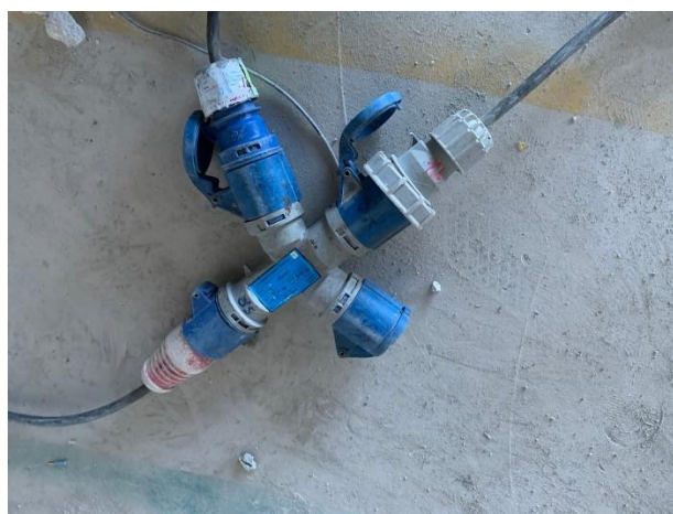
รูปที่ 2.1-28 จุดเชื่อมต่อการใช้ไฟฟ้าภายในบริเวณพื้นที่โครงการ
